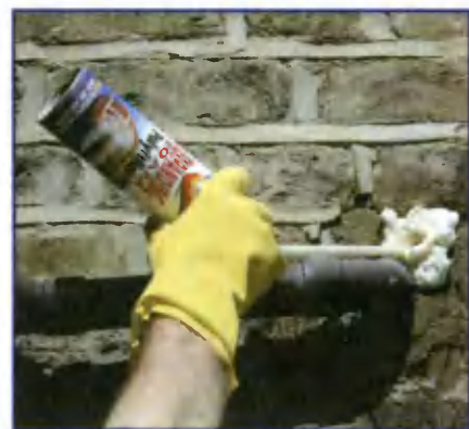
Большие скрытые полости в кладке заполняют расширяющейся монтажной пеной.
